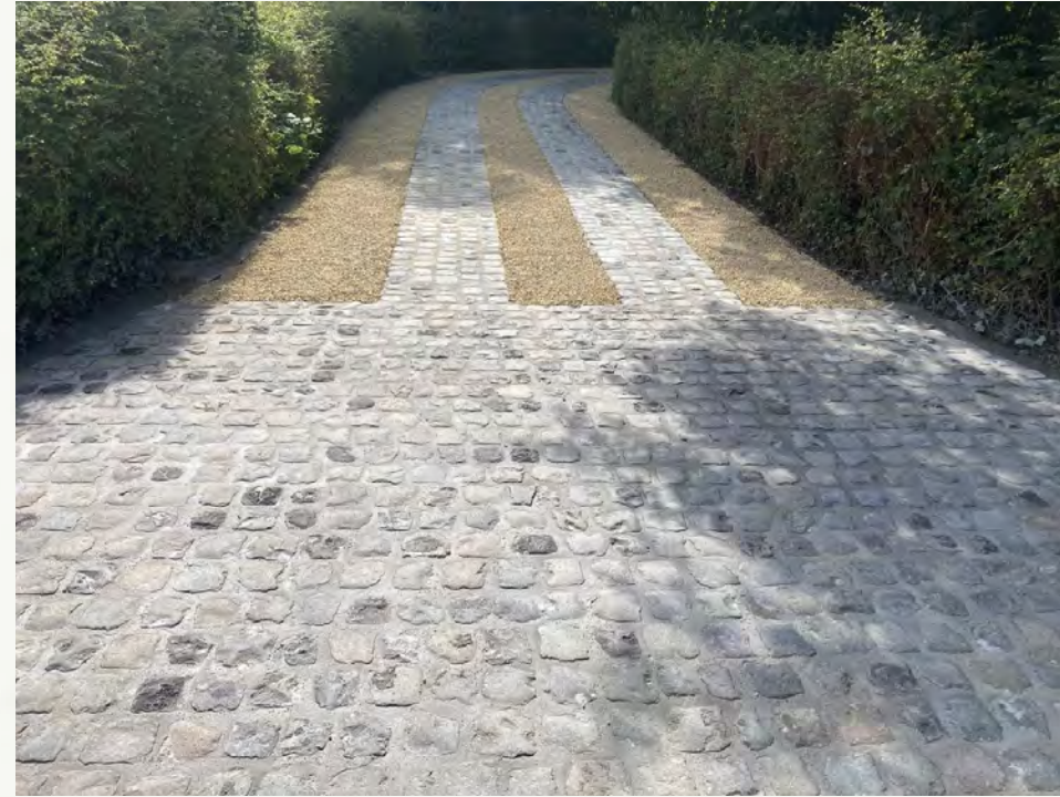
Verharding in combinatie met dolomiet
